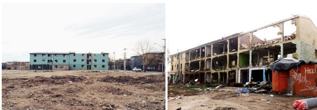
Figura 4. Imágenes de demoliciones en Francisco Coloane, 2013-2015
